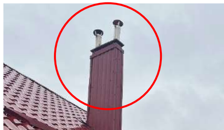
установка зонтов на дымовых каналах
