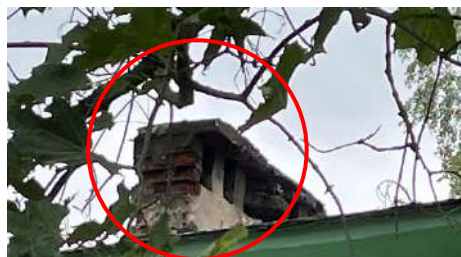
разрушенный оголовок дымовых и вентиляционных каналов
