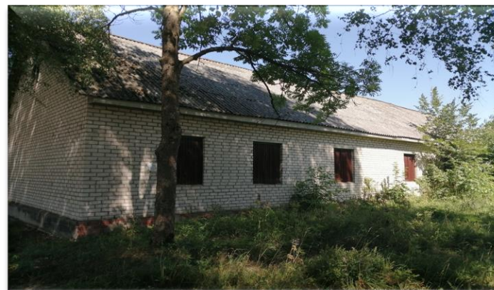
Заездный дом, Глубокский район, д. Ивесь, ул. Школьная, д.35
