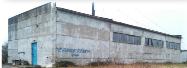
школа и котельная в аг. Гатовщина
