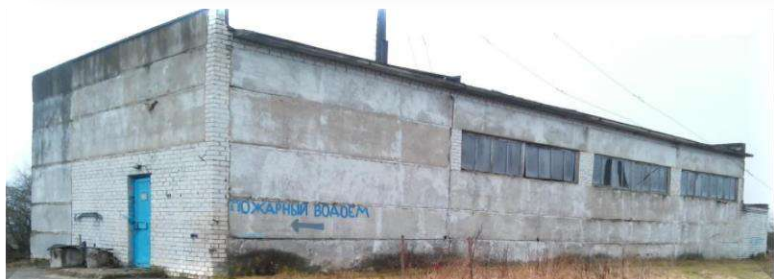
школа и котельная в аг. Гатовщина
