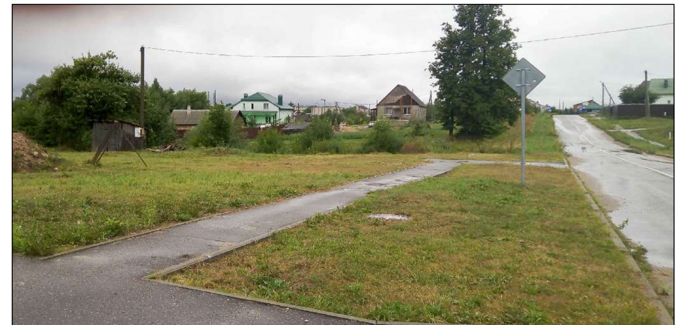
Вид места примыкания продления ул. Островского к ул. Воронкевича
