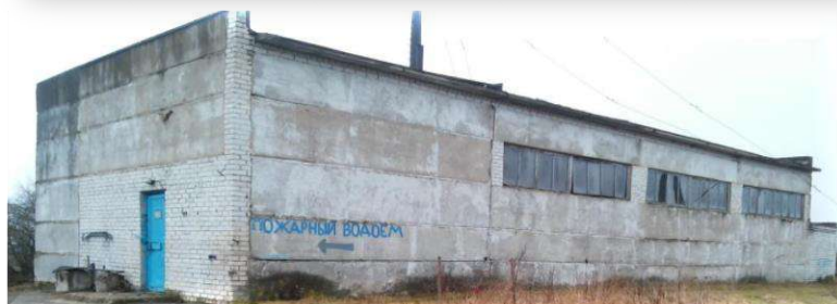
школа и котельная в аг. Гатовщина
