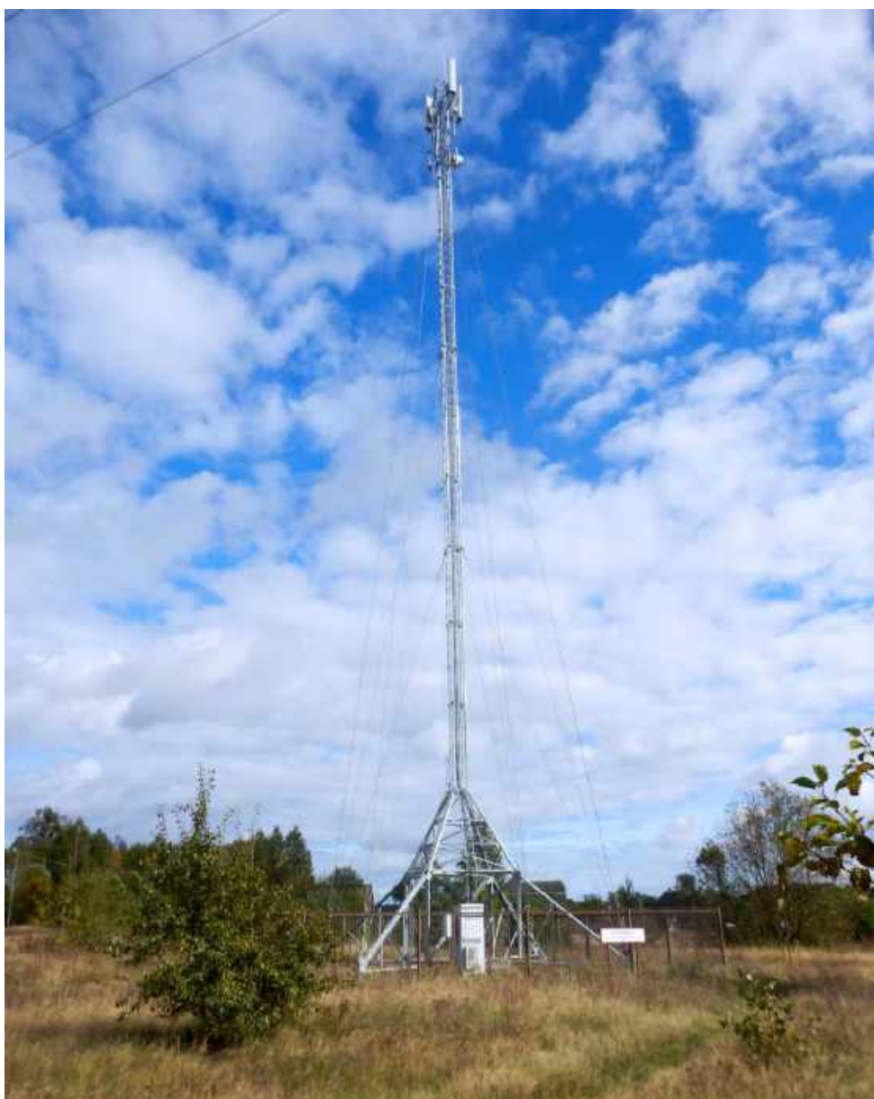
Рисунок 6 – Внешний вид металлоконструкций мачты высотой 39 м (объект-аналог)
